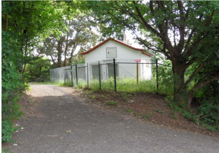
Das alte Gashäuschen in neuem Glanz
